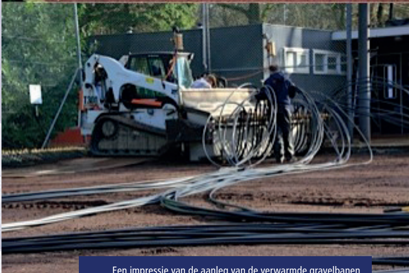
Een impressie van de aanleg van de verwarmde gravelbanen (foto: Wolter Blom)
